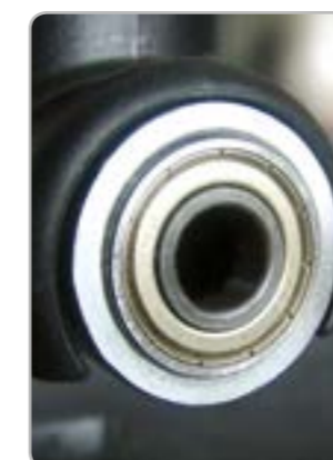
Drehgelenke 2-fach kugelgelagert
